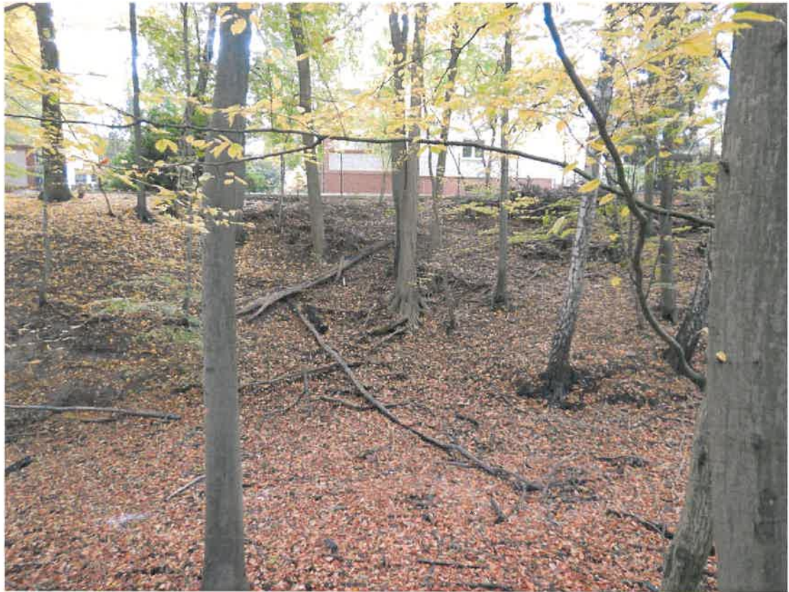
Fot. 4. Widok zachodniej części osuwiska.
