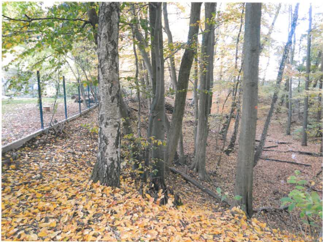
Fot. 3. Górna krawędź osuwiska dochodząca do ogrodzenia.
