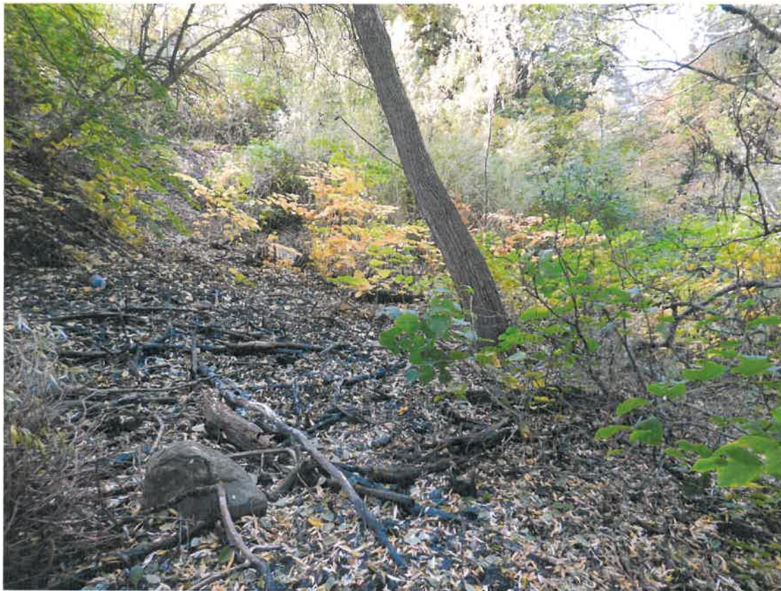
Fot. 1. Zniszczone umocnienia skarpy na jęzorze osuwiska.
