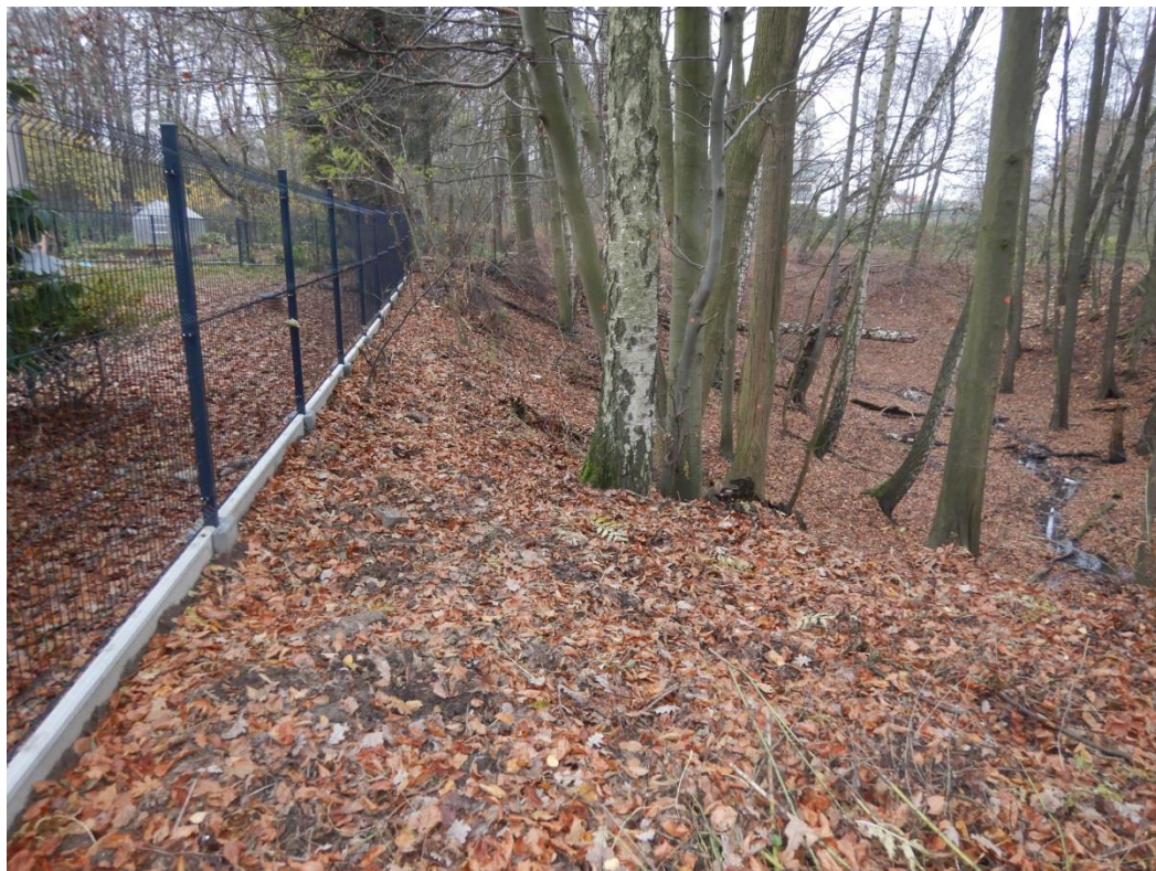
Fot. 4. Górna krawędź osuwiska dochodząca do ogrodzenia.
