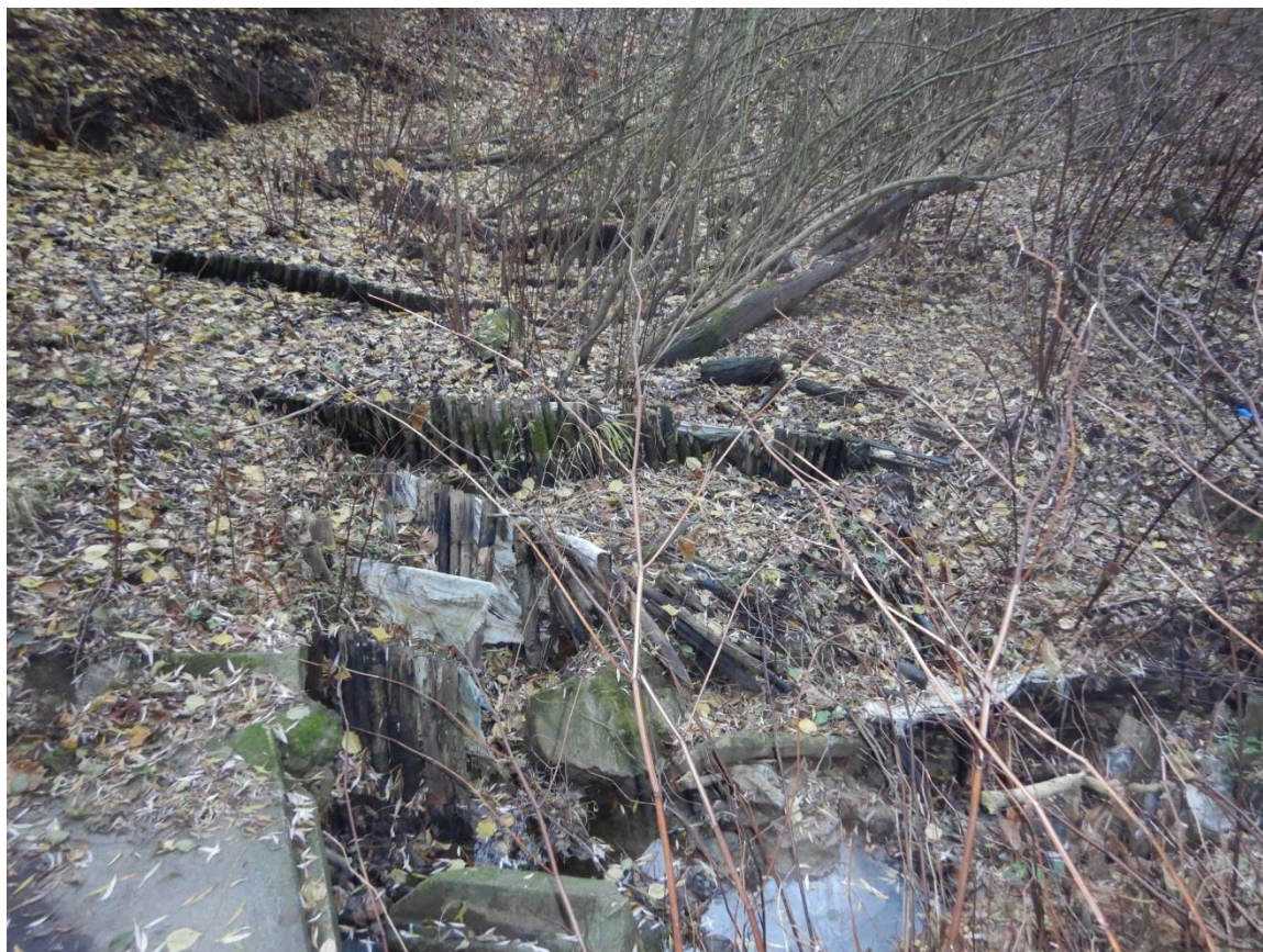
Fot. 3. Zniszczone umocnienia skarpy przykorytowej na jęzorze osuwiska.
